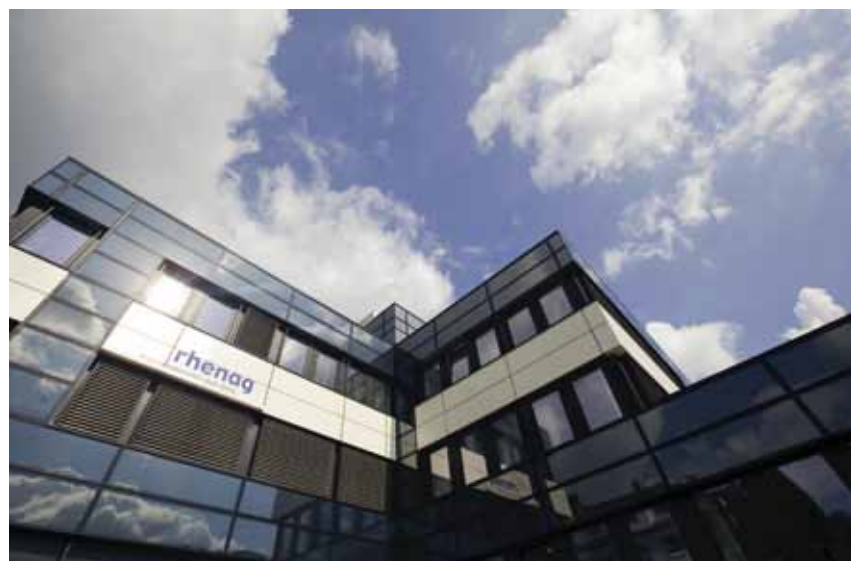
Photovoltaik-Fassade am rhenag-Verwaltungsgebäude in Siegburg. Foto: rhenag Rheinische Energie AG, Köln
